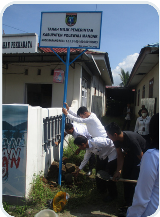
Pemasangan Plang Kompleks SPMA
