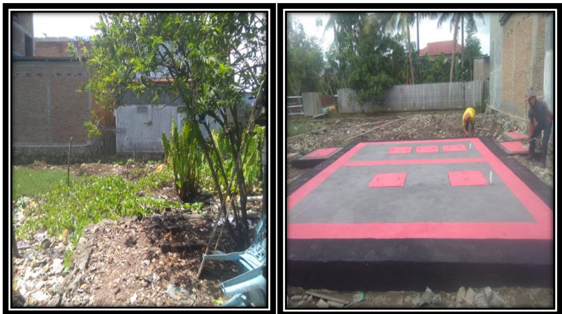
Gambar 3.7 Dokumentasi Kegiatan Pembangunan Sarana dan Prasarana Sanitasi Kel. Lantora Kec. Polewali
