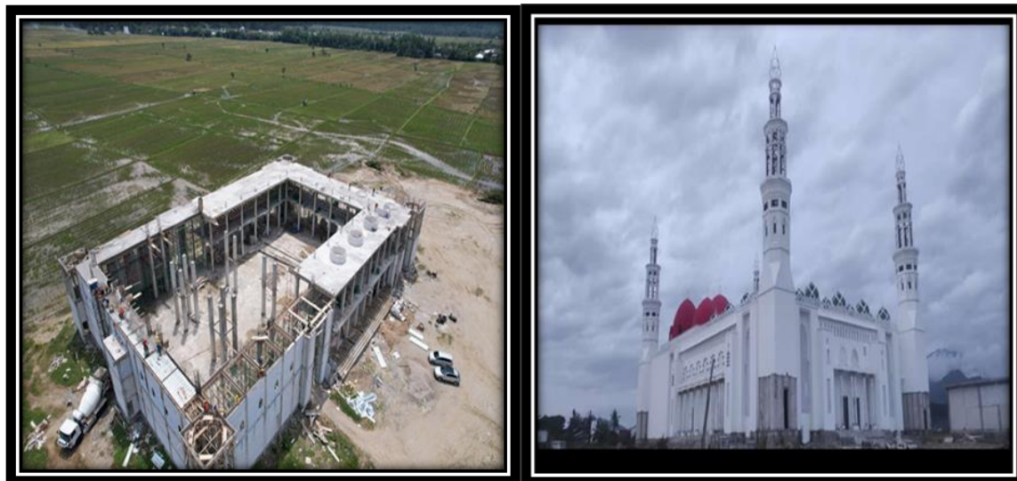
Gambar 3.8 Dokumentasi Pembangunan Masjid Jalan Kartini
