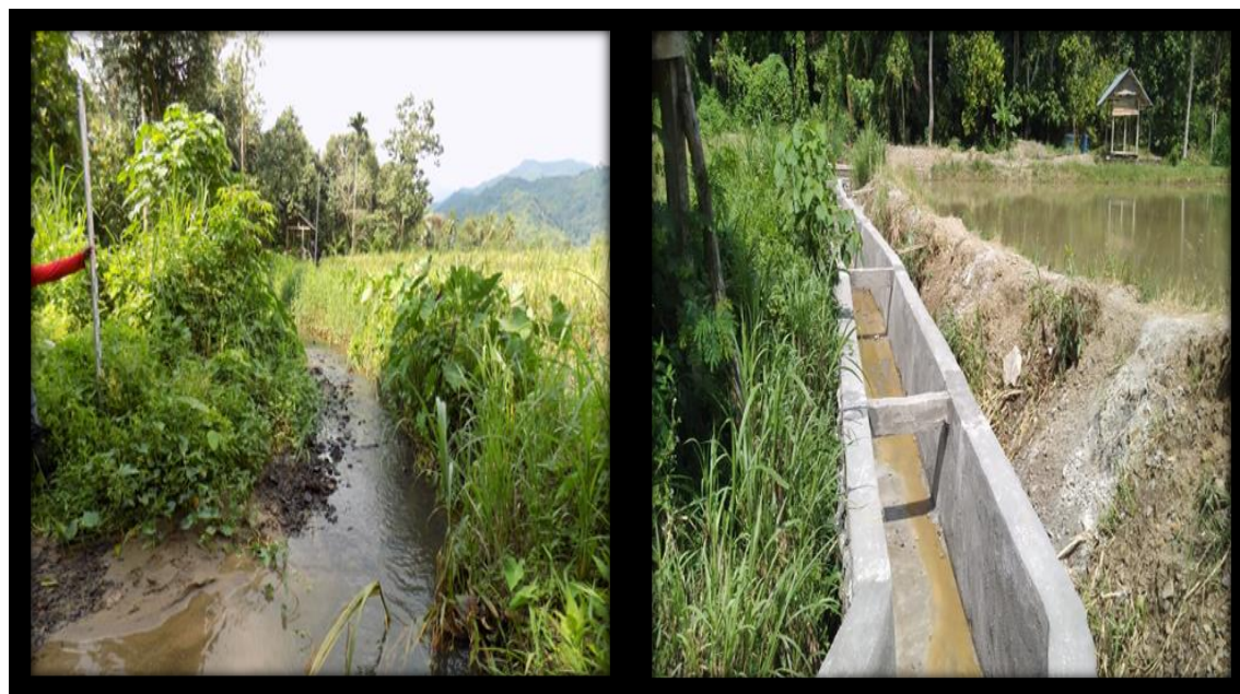
Gambar 3.5. Rehabilitasi Jaringan Irigasi Permukaan D.I Alapahang Desa Riso
