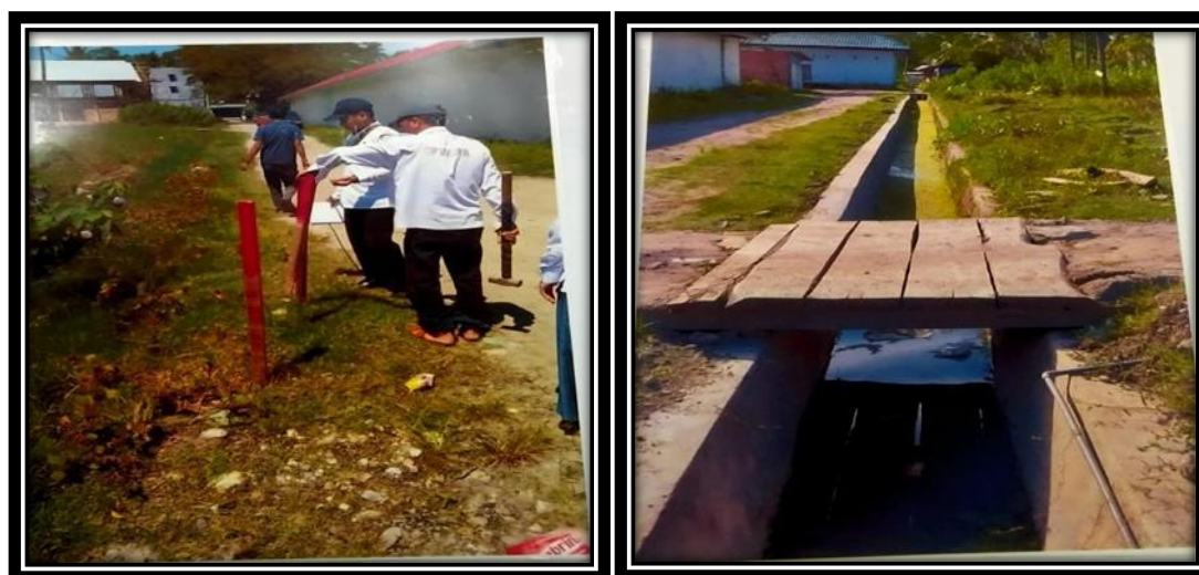
Gambar 3.7 Dokumentasi Kegiatan Pembangunan Drainase Pasar Tinambung
